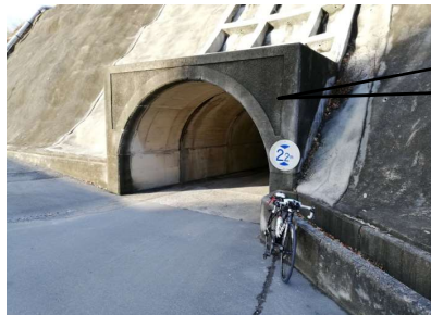
通過チェック② 大矢トンネル
