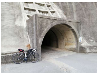
←通過チェック②大矢トンネル
